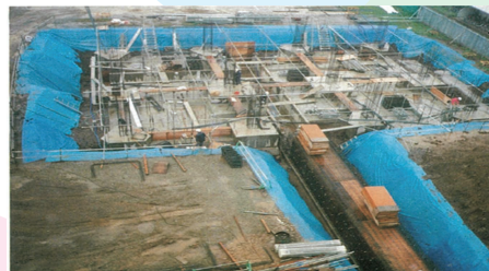
基礎工事の様子
