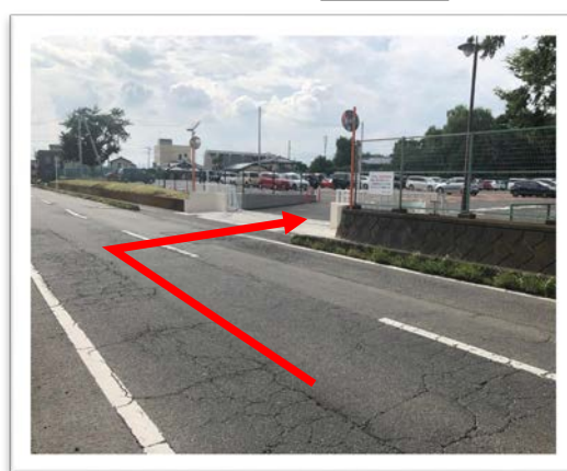
大駐車場入口(前橋市方面から)
