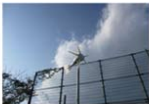
風力発電機 (最大130w)
