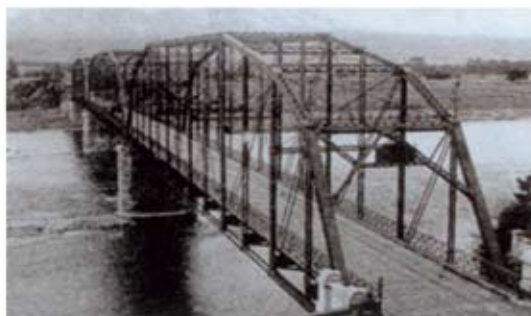
明治34年建設当時の橋梁
